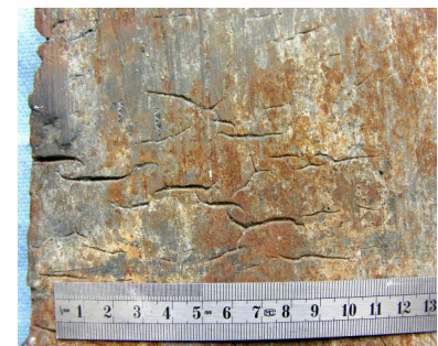
Bild 4: Risse im Kupolofen-Mantel (Kesselstahl P11)
