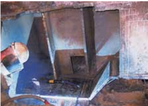
Bild 1a: Schweißreparatur von Wandblech (Pos. 3) und Tragarm
