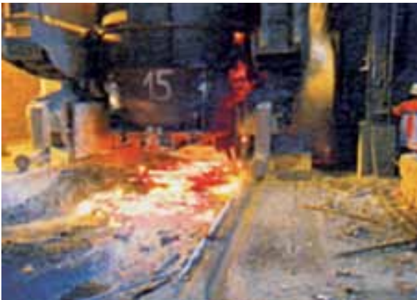
Bild 1: Transportwagen mit Pfanne, unmittelbar nach dem Schaden
