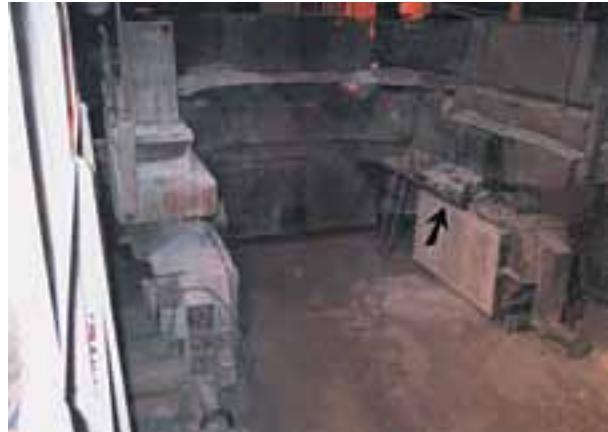
Bild 1b: Nach der Reparatur, Blick auf den Tragarm (Pfeil)
