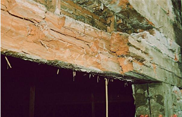
Myzele an den Ziegelsteinen und an den Holzbalken mit Spalierlatten. Interessant ist die Richtung des Wachstums und Ausbreitens der Myzele, ganz eindeutig aus dem abgebrochenen Altbau in Richtung Nachbarbau hinein.
