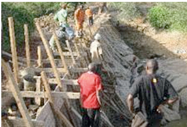
Die Selbsthilfegruppe Athiani bei den Arbeiten an einem Sanddamm.
