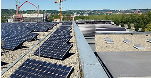
Abb. 2: Ansicht der Draufsicht Dachfläche
